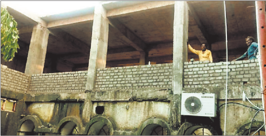
चल रहा कंपोजिट बिल्डिंग का निर्माण कार्य ।
